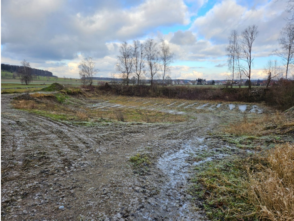
Blick über die noch zu verfüllende Grube mit Blick auf das angrenzende Gehölz am nordöstlichen Rand (Stand: Januar 2025)
